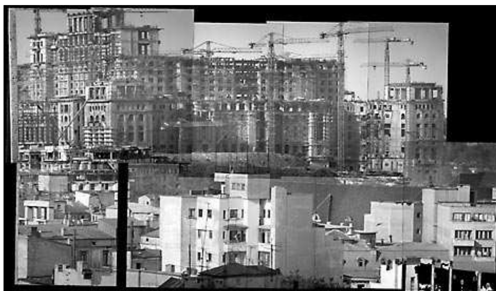
Figure 31 – Photographie du chantier de la Maison du Peuple avec ses dizaines de grues qui, dans un rythme frénétique, s'agitaient jour et nuit au nom de la grandeur voulue par Ceausescu. (Collection S. Vasilescu).
