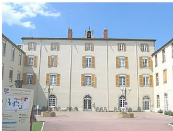
Figure 6: Entrée principale de l'EHPAD 110 .
