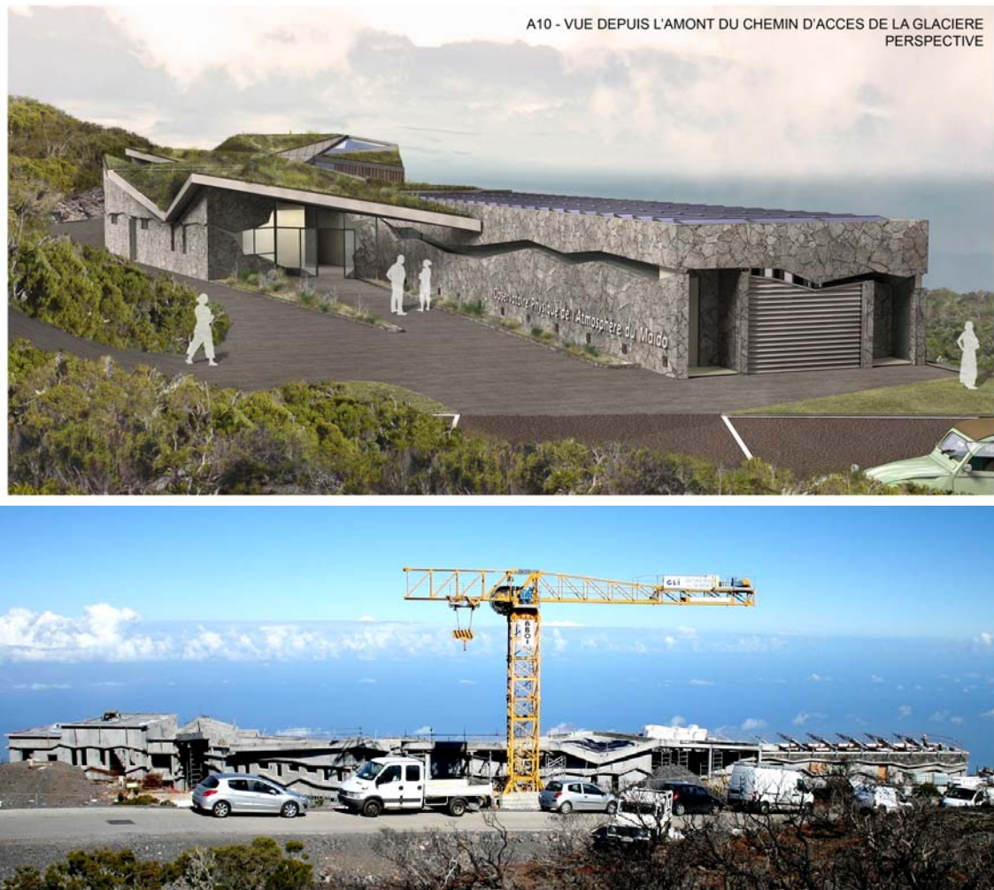
Figure 7.4: Vue du chantier et vue idéalisée de la station d'observation du Maïdo - Sources : http://opar.univ-reunion.fr/ (en haut) et Alexis Merlaud (en bas).
