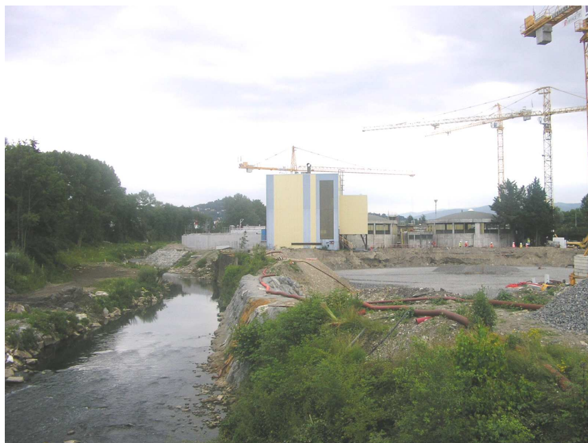
Photo 22 : Le Furan, incinérateur actuel, chantier du nouveau clarificateur (Y. BENMALEK, 29.06.2007)
