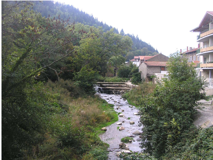
Photo 27 : La Déôme au Quartier de la Gare à Bourg-Argental (Y. BENMALEK)
