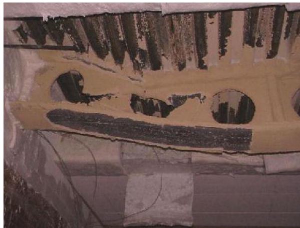
Figure 3.4 : Poutre P1 après l'essai [RFC 06]
