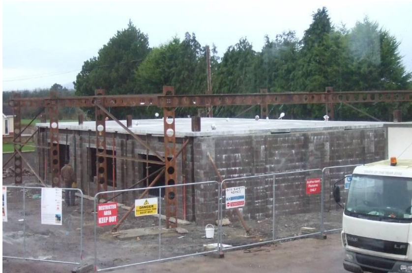
Figure 2.1 : Vue d'ensemble du bâtiment avant l'essai
