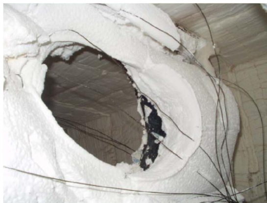
Figure 3.5 : Retrait de la peinture intumescente [BAI 04b]
