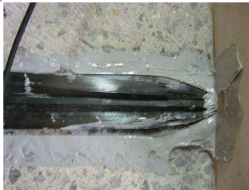
Figure A3- 19 : Fibres endommagées de la lamelle ancrée lors des essais cycliques CLAc_1 (photo prise lors des derniers cycles à 33,9 kN).
