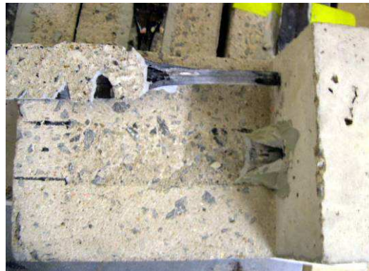
Figure A2- 17: mode de rupture de la lamelle ancrée lors de l'essai CLA1.
