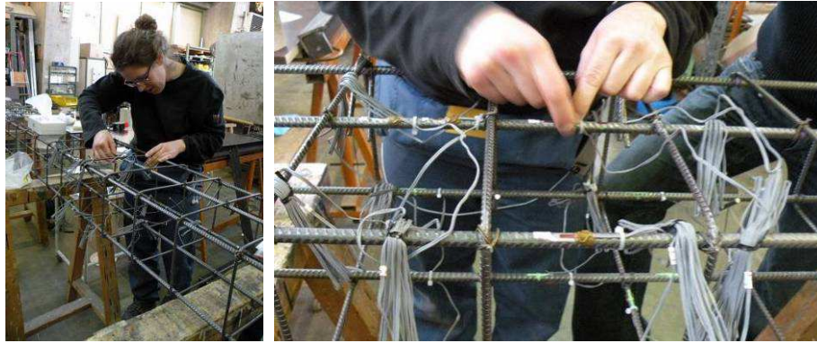
Figure 3-25 : Mise en place des jauges de déformation sur aciers.
