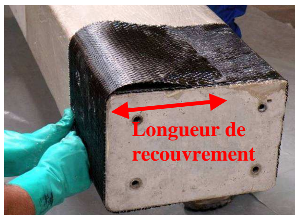
Figure 3-15 : Zone de recouvrement des bandes de PRF à base de tissu.
