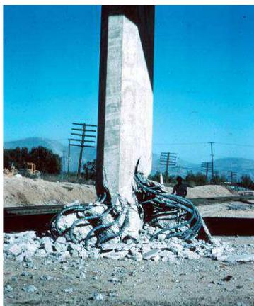
Figure 1-4 : Rupture par manque de confinement (San Fernando, 1971).
