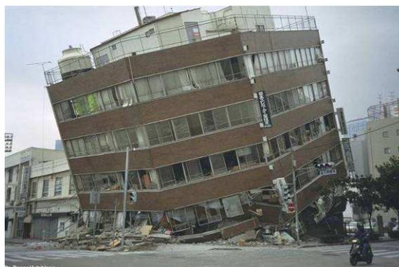
Figure 1-3 : Effondrement de l'étage inférieur du bâtiment (Kobe, 1995).
