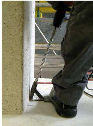
*Injection de résine époxy dans le trou et encollage de la lamelle et de la face du poteau*
