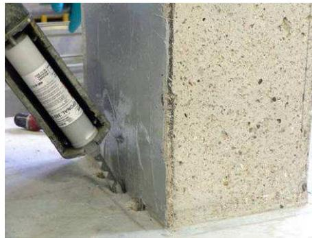
*Insertion de l'ancrage dans le trou prévu à cet effet et marouflage de la partie plane de la lamelle sur la partie courante du poteau*
