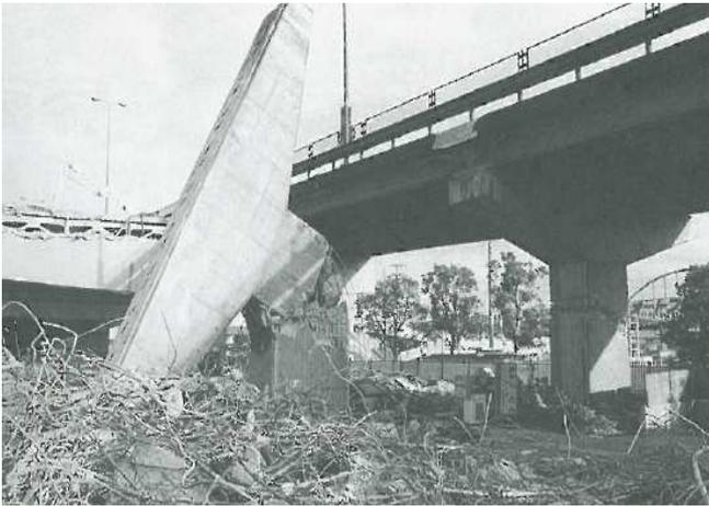
Figure 1-6 : Rupture d'une pile par flexion-cisaillement (Kobe, 1995), d'après [Priestley et al., 1996].
