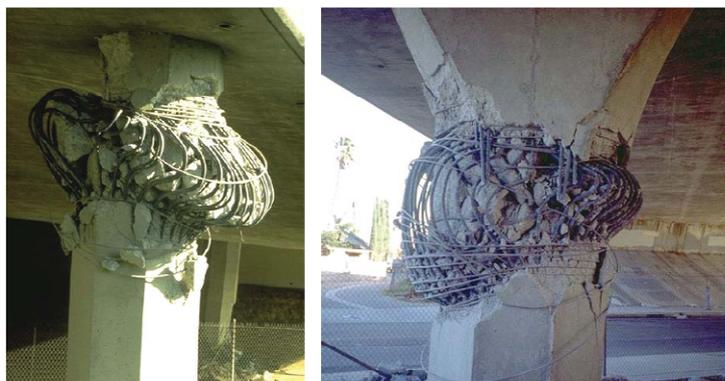
Figure 1-8 : Rupture de piles de pont par cisaillement lors du séisme de Northridge, 1994 (d'après [NISEE]).
