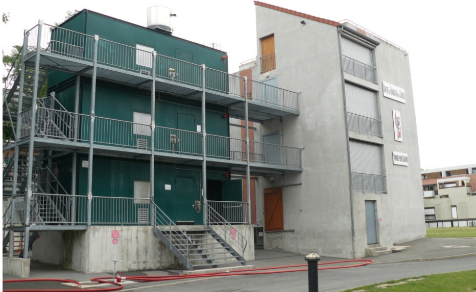
Figure 109 : Maison du feu. Cette structure d'entraînement (préfabriqué vert) permet au pompier de perfectionner sa technique d'intervention en infrastructure urbaine.
