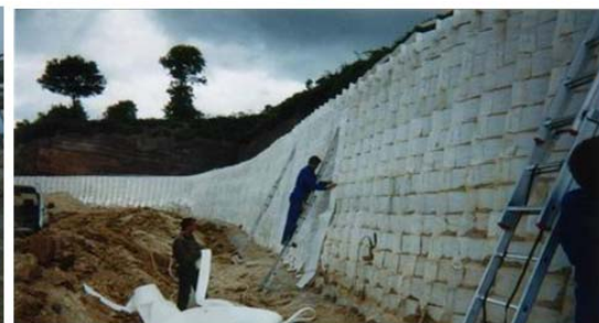
Raidissement de parois de CET CET, Le Verger (35)
