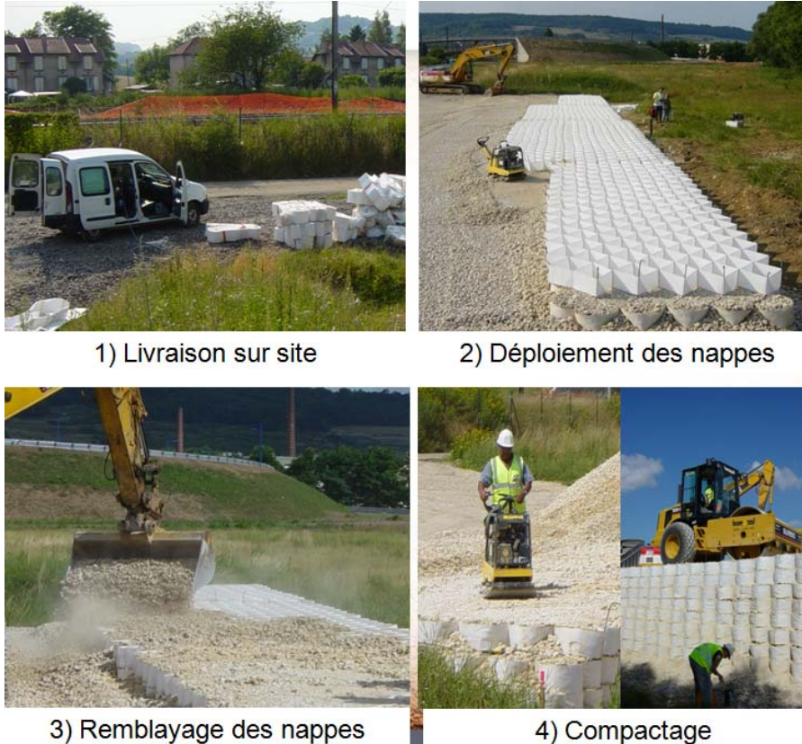
Figure 4. Etapes de mise en œuvre.
