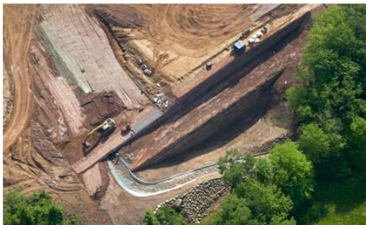
Soutènement de grande hauteur (15 m) Contournement nord, Brive la gaillarde (19)
