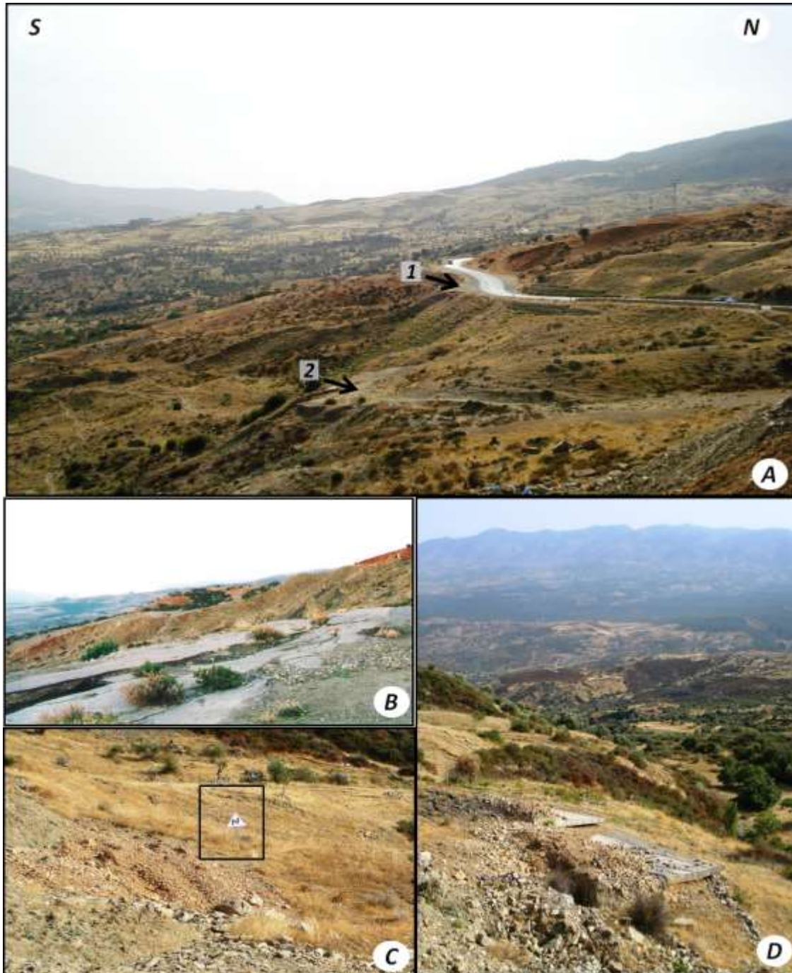
Figure IV-20 : A : Vue générale de la route nationale N°2 affectée par le glissement de Bou Halla, avec la route actuelle (1), et l'ancienne route détruite et déplacée par le glissement de Bou Halla sachant que la 2 avait comme ancienne position la 1 ; B : Détail de la route détruite par une des phases du glissement ; C : Panneau signalétique déplacé avec la section de la route d'environ 20m lors de la réactivation du glissement en hiver (2010) ; D : Mur de soutènement disloqué par la poussée continue du glissement de Bou Halla, de Mastere et al., 2010 , adaptée.
