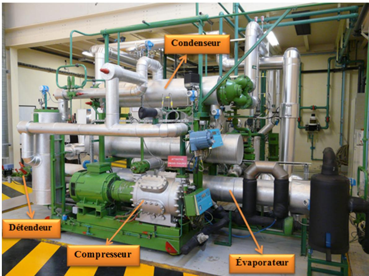
Figure 2. Photo de la machine frigorifique à pistons (EDF, site des Renardières)
