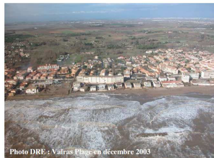
Fig. 4 – Valras (Hérault) menacée par la mer en décembre 2003 (photo DRE)
