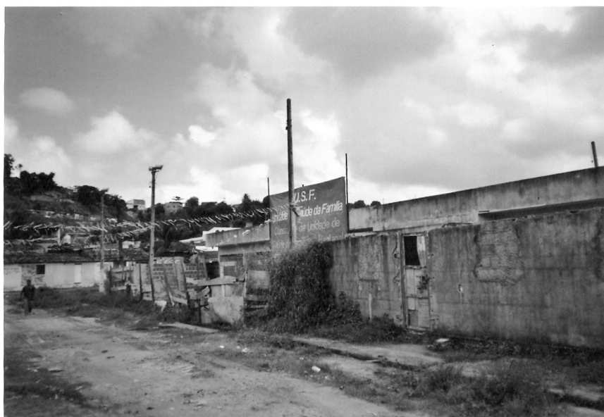
Figure 30: L'unité de santé de Pantanal en construction en 2006. © A. Faya Robles.
