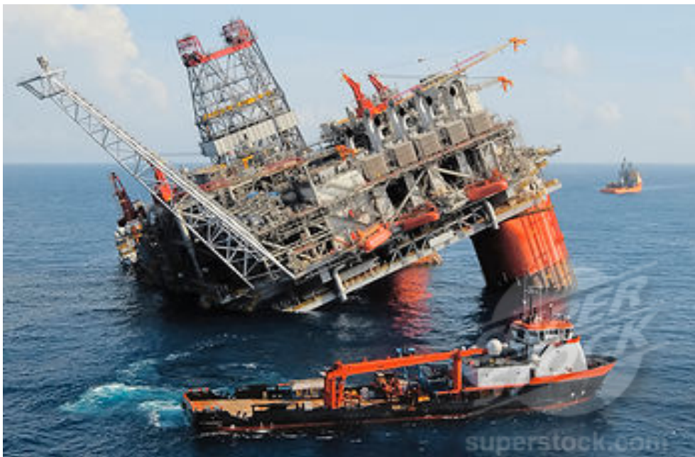
Fig.1.1: Plateforme pétrolière endommagée par l'ouragan Dennis ( http://www.superstock.com )
