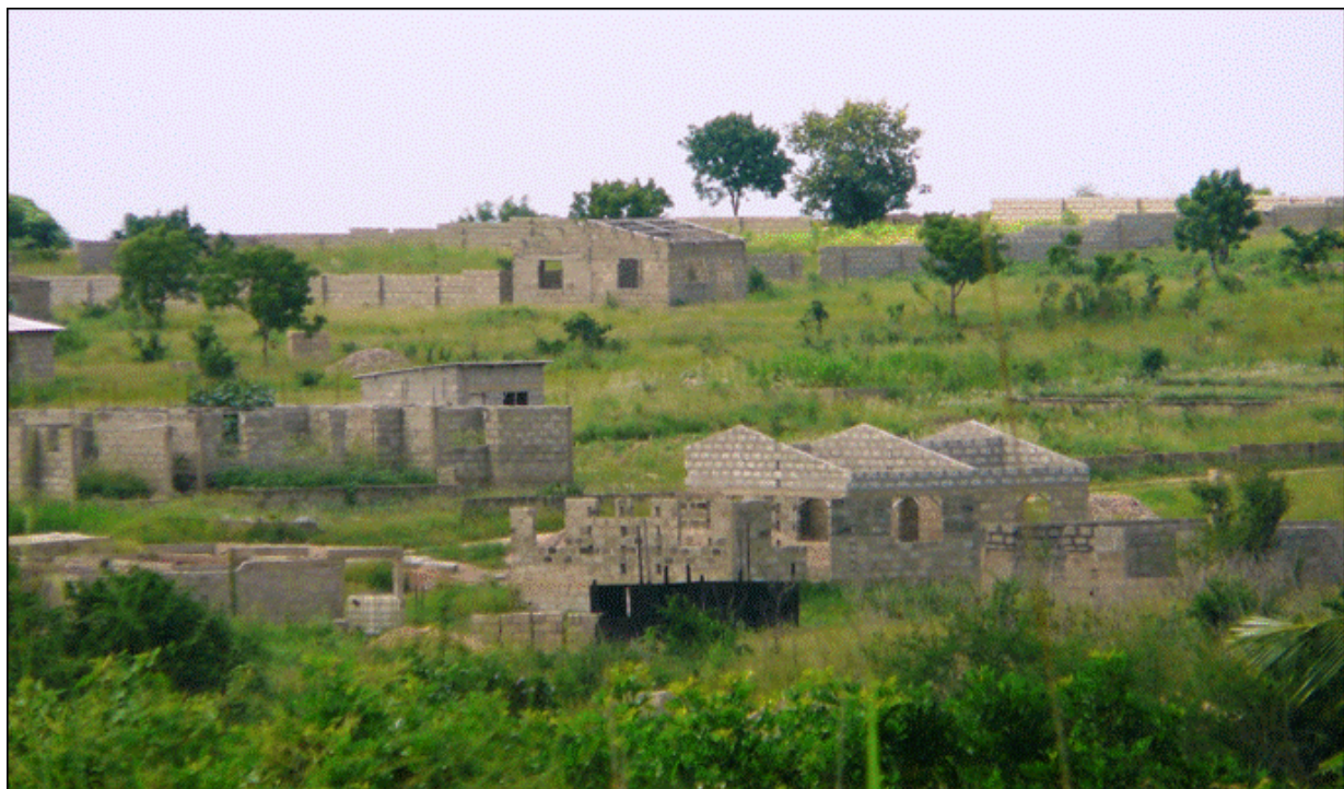
Photo 3: La zone tampon d'Accra en construction
