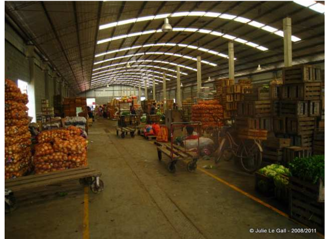
c. Vue de l'intérieur de la halle, 2010. Les côtés de la halle ont été construits en parpaings de béton. Seules quatre ouvertures ont été conservées pour le déchargement.
