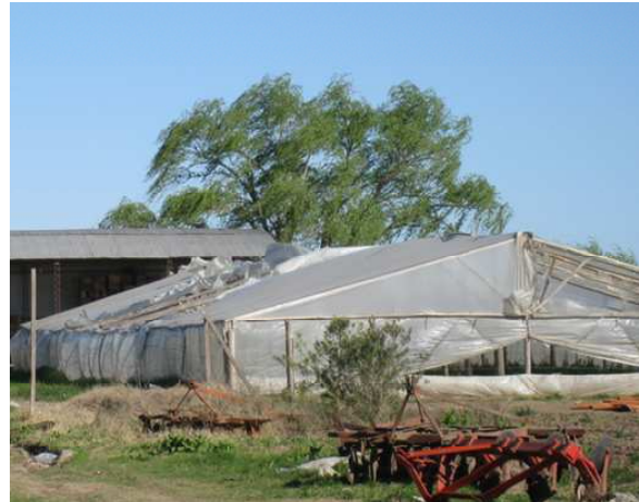
b. Serre de type « grande chapelle » Plus basses et plus larges, ces serres sont privilégiées pour les cultures de légumes feuilles.
