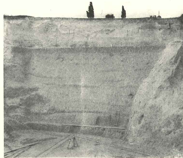
FIG. 294. — Carrière Robin à Beausembiant (1945) dans les limons anciens. Les cailloutis constituent des lignes sombres sauf au sommet. Les rails pour les wagonnets donnent l'échelle.
