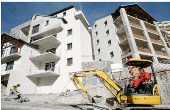
En plein cœur de Gourette, la résidence Le Portillo dans son état d'avancement actuel. PHOTO THIERRY SUIRE
