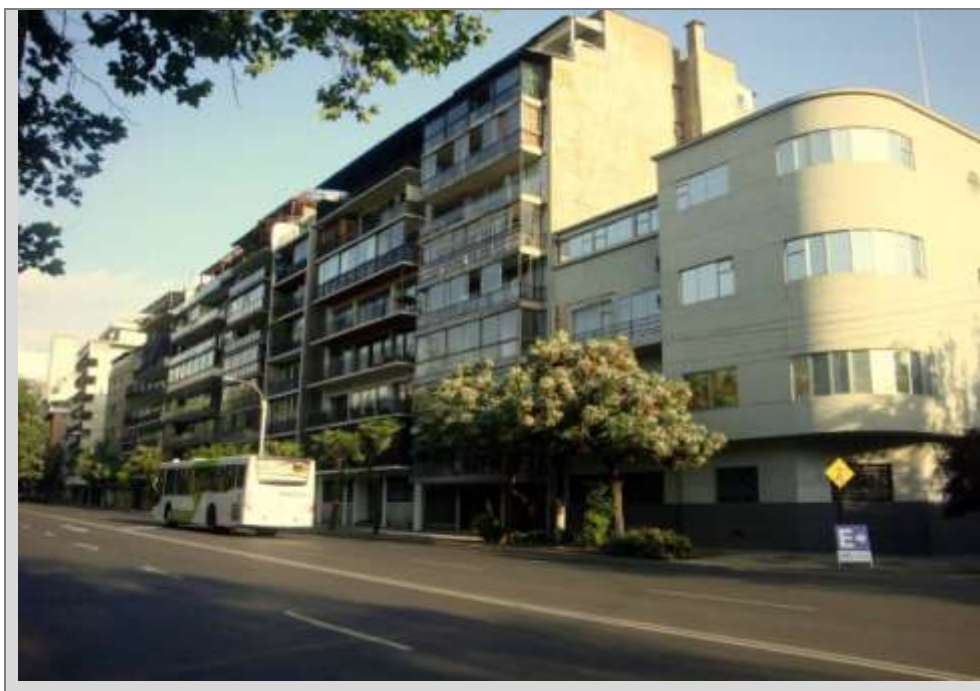
Figura 6- 8. Vista al exterior del departamento de Teo (caso n° 6-2), barrio Bellas Artes
