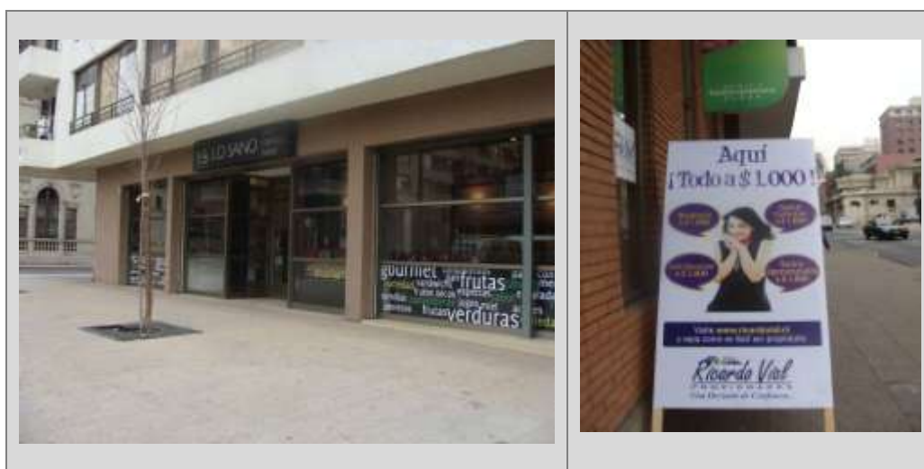
Figura 7- 3. Vista exterior del departamento de Emperatriz (caso n°7-26)
