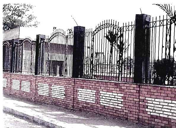
Figure 36 : Clôture du parc de Fustât, Le Caire
