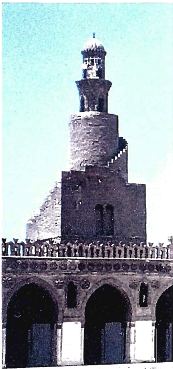
Figure 67 : Minaret en spirale de la mosquée Ibn Tûlûn, Le Caire.
