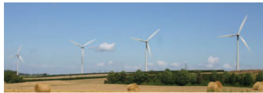
FIG. A.3: Parc d'éoliennes [Source : Observ'ER. Crédits photos : Boralex].
