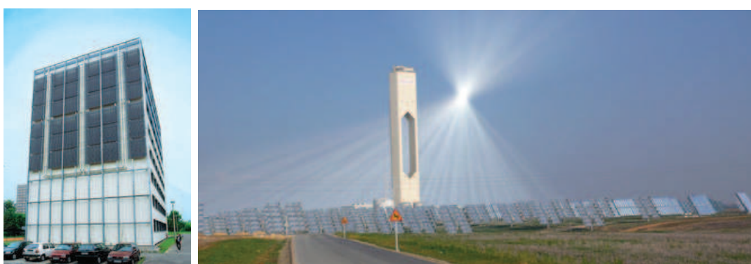
FIG. A.5: Energie solaire thermique [Source : Observ'ER. Crédits photos : Viessman, Abengoa].
