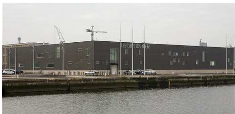
Illustration 7. Façade principale des Bains des Docks 3
