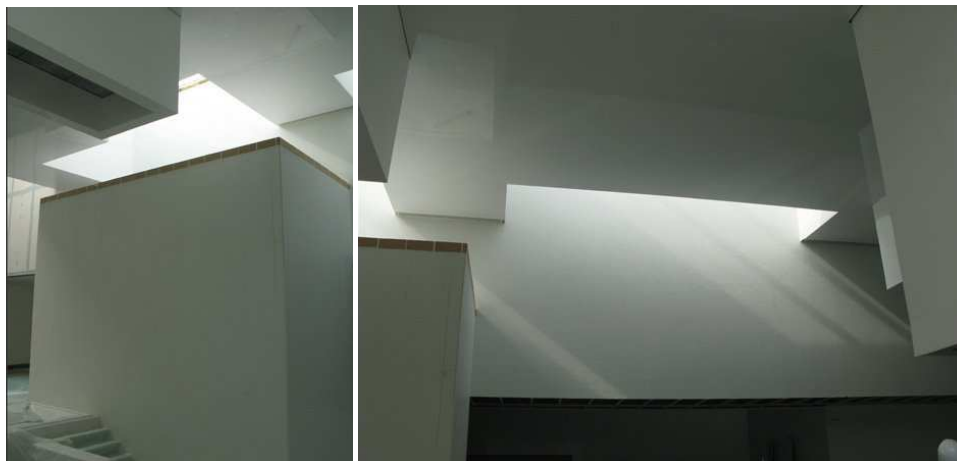
Illustration 1. Photographies des volumes dans l’espace balnéothérapie pendant le chantier 3
