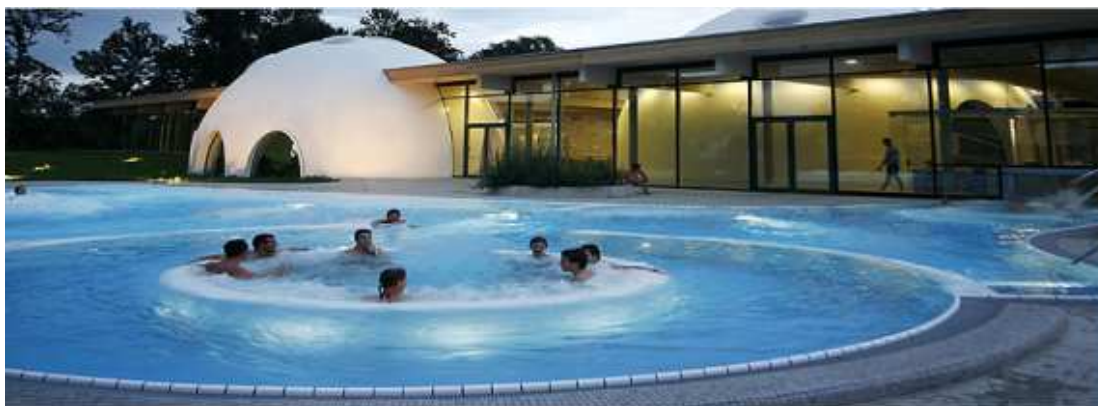
Illustration 63. Photographie du bassin extérieur 1
