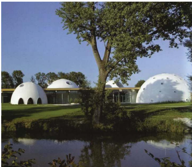
Illustration 16. Thermes de Bad Aibling, façade sud des thermes 2
