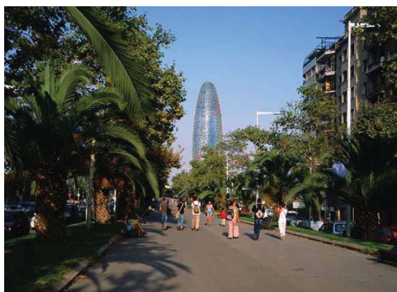
Illustration 11. Tour Agbar, Immeuble de bureaux, Barcelone, Espagne, 1999-2005 2
