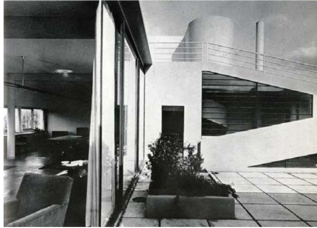
Illustration 21. Le Corbusier, architecte. Villa Savoye, Poissy, 1928-1931. Premier étage et rampe d'accès à la terrasse (extrait du livre de Tim Benton Les Villas de Le Corbusier, éditions Philippe Sers) 1
