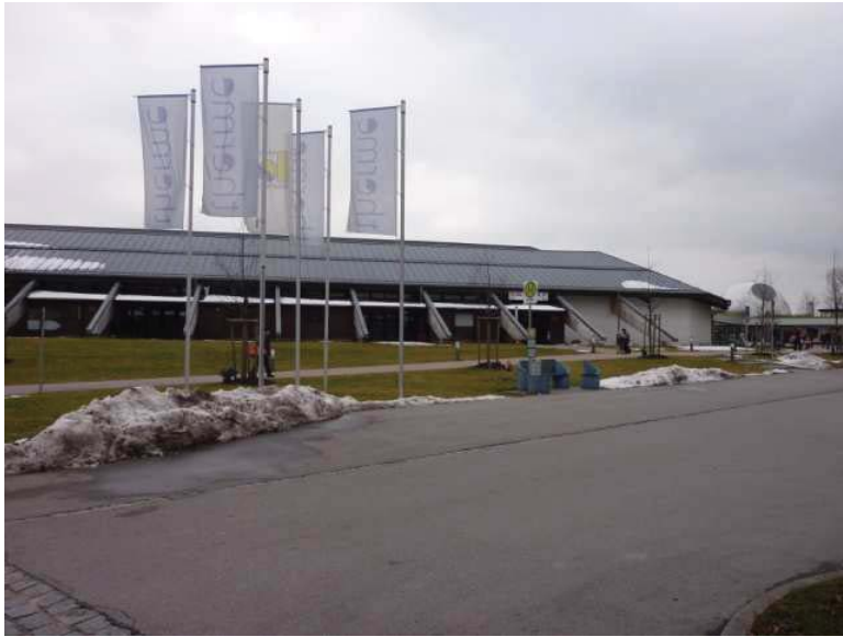
Illustration 14. Patinoire à côté de laquelle doit s'insérer le bâtiment des Thermes de Bad Aibling 1
