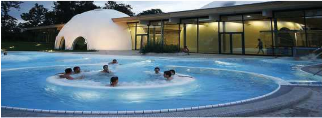
Illustration 63. Photographie du bassin extérieur 1
