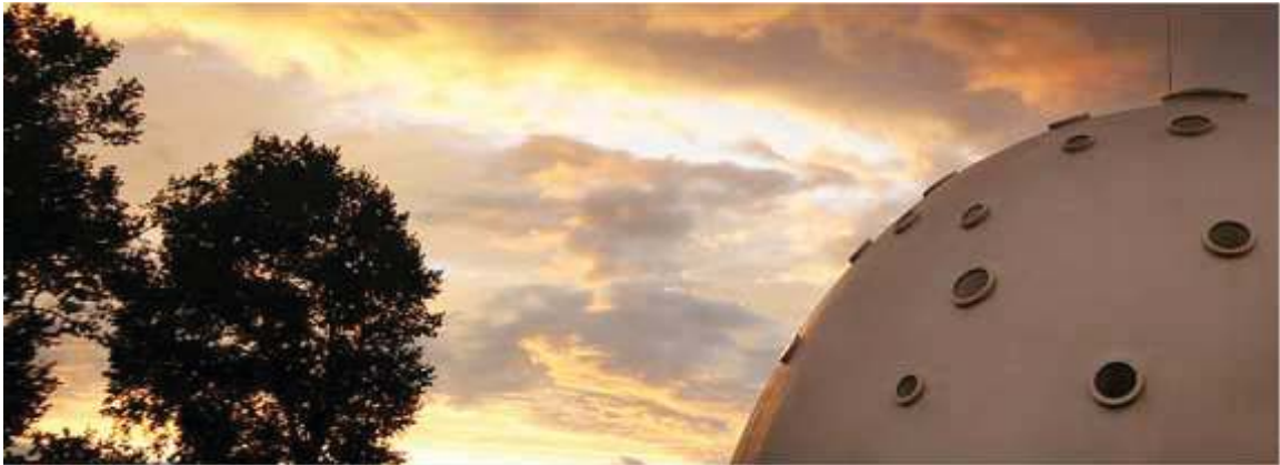
Illustration 13. Thermes de Bad Aibling, la coupole des sens vue depuis l'extérieur 1
