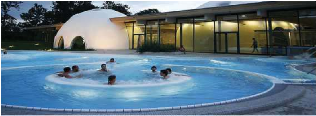
Illustration 63. Photographie du bassin extérieur 1
