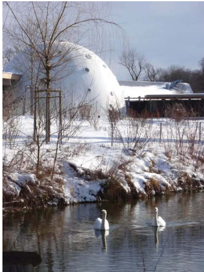
Illustration 13. Thermes de Bad Aibling, vue de la façade sud 1
