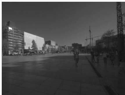
FIG. 5.1 – Exemple de façades à "l'infini".
