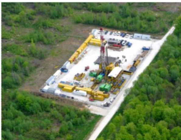
Photo aérienne du forage EST433
