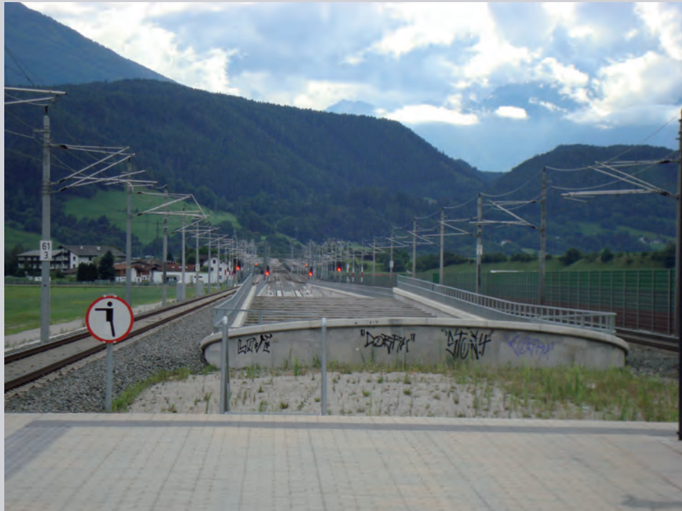
Photo 26. Convergence de la ligne historique de la vallée de l'Inn et de la nouvelle UnterinntalBahn à la sortie de la gare de Fritzens-Wattens
