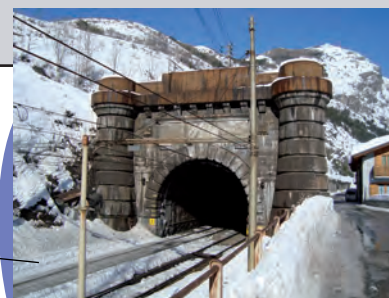
Portail sud du tunnel du Fréjus. K. Sutton, janvier 2009.
