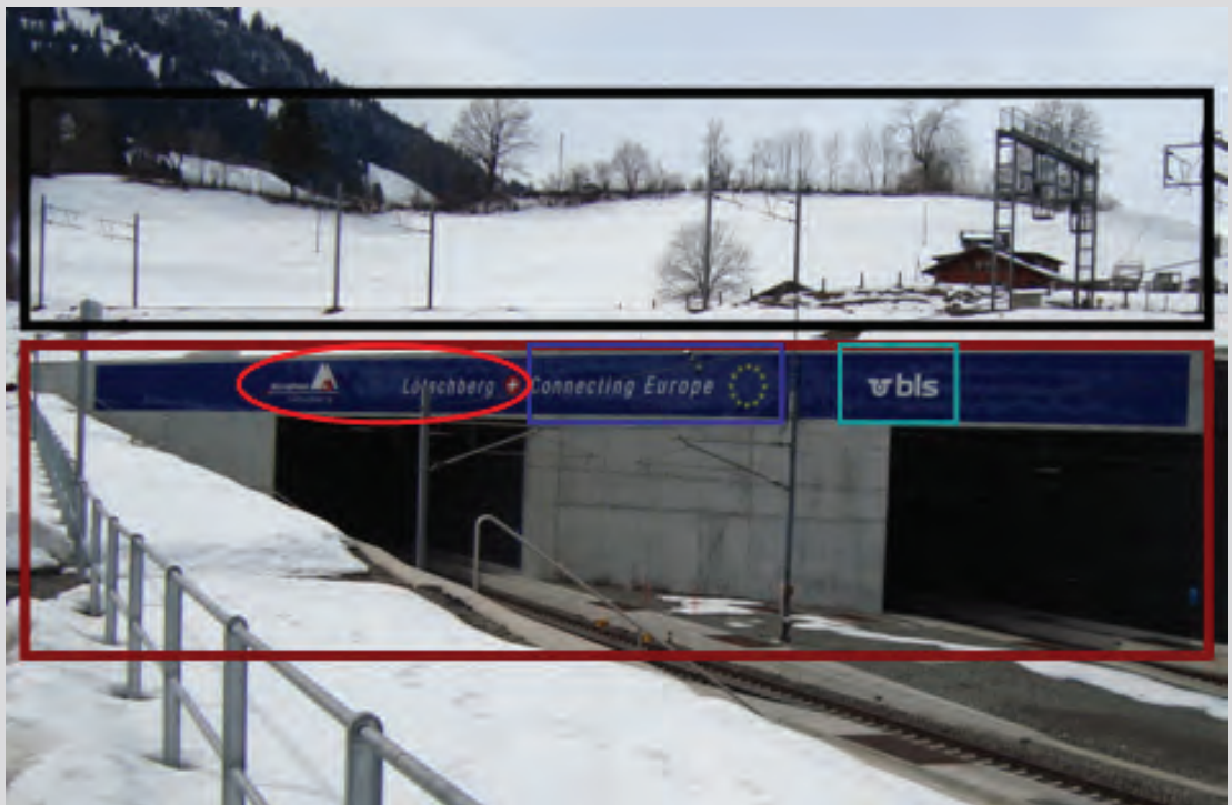
Photo 3. Portail nord du tunnel de base du Lötschberg.
