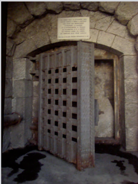
Photo 27. Porte posée afin de préserver la galerie du Simplon excavée en 1904 de l'inondation suite au dégagement d'une importante poche d'eau. Cette porte est aujourd'hui exposée au musée de Rumine.
