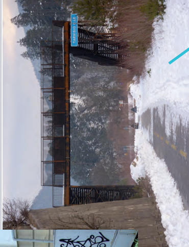
Vue de l'ancienne passerelle piétonne qui permettait d'enjamber la voie unique internationale. Notons que la piste est déneigée l'hiver pour permettre la circulation piétonne entre les sites de la station. K. Sutton, janvier 2010.
