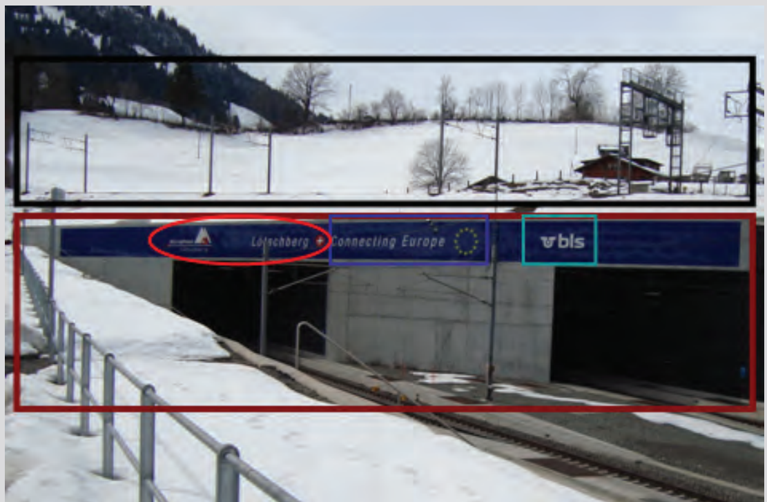
Photo 3. Portail nord du tunnel de base du Lötschberg.
