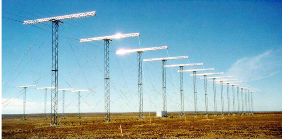
FIG. 1.8 – Vue générale du radar de Kerguelen, avec les 16 antennes qui constituent le réseau principal et, en arrière plan, les 4 antennes du réseau interférométrique.
