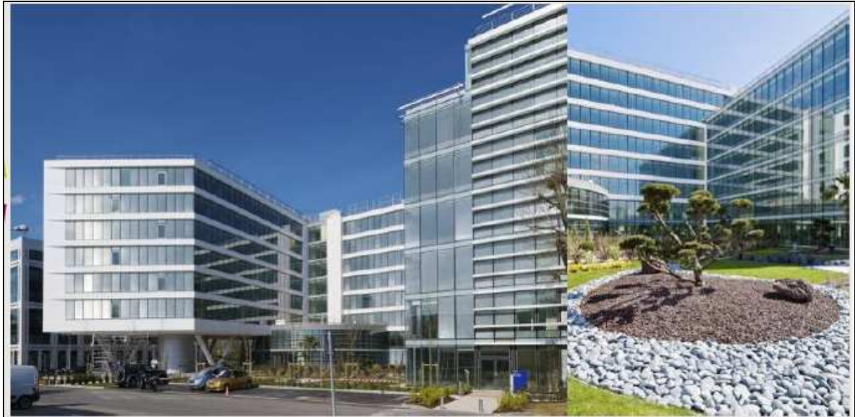
Photo 3 – Immeuble Miami de la zone d'activités économiques SILIC, 20.000 m 2 SHON
