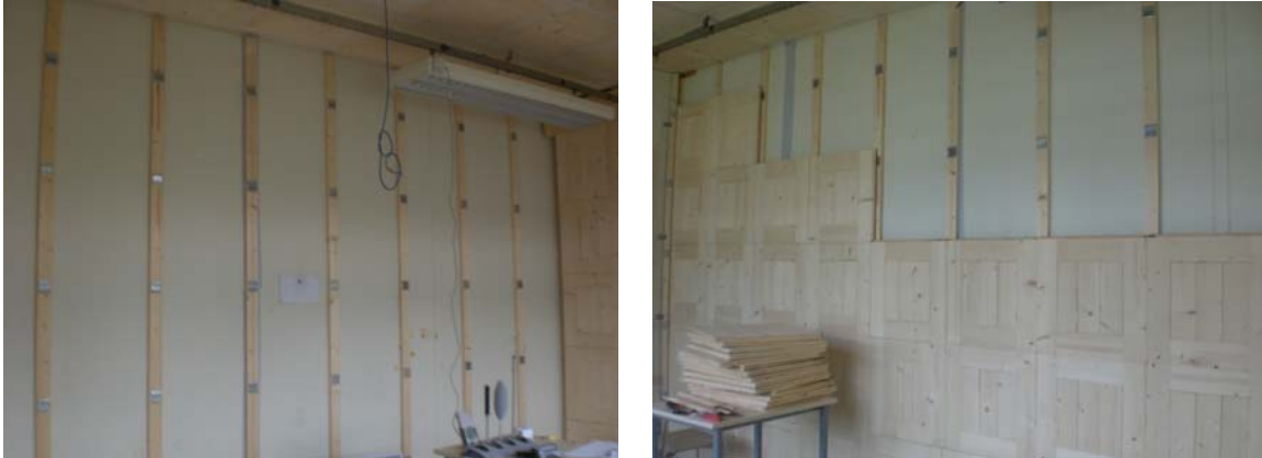
Figure 4-4 : Montage des revêtements en bois des murs de la cellule
