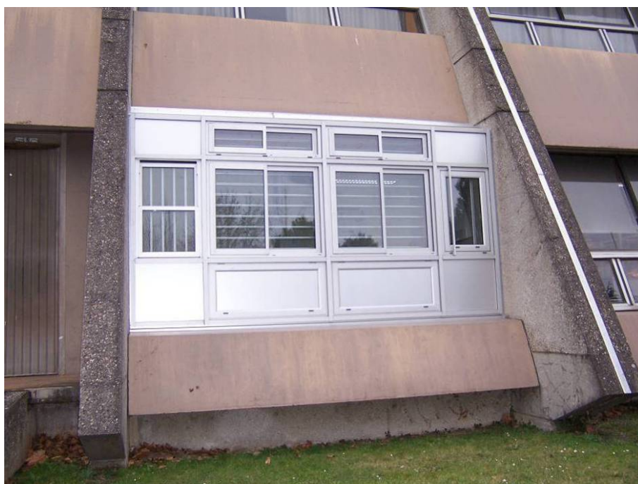
Figure 4-1 : façade extérieure de la cellule Hybcell
