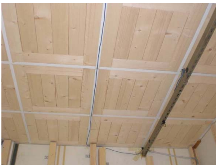
Figure 4-9 : plafond en bois
