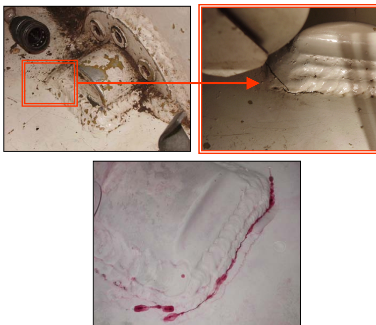
Figure 122 : fissure de fatigue dans une structure mécano-soudée
