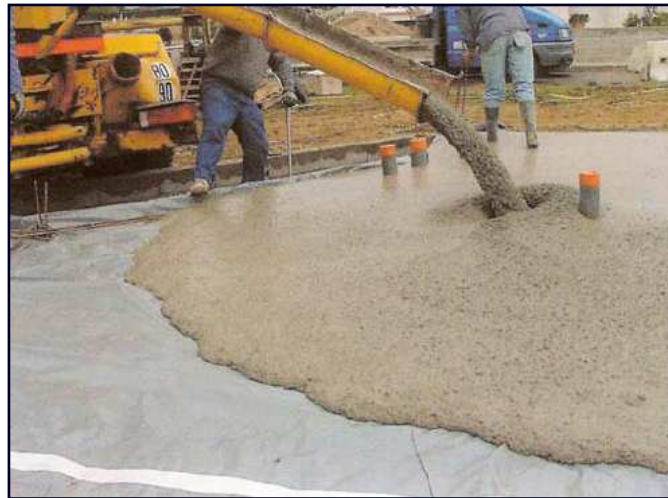
Figure 1.2 - Coulage d'une dalle en béton autoplaçant.
