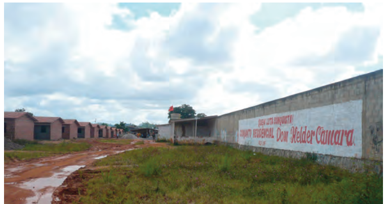
10d. Les maisons en construction et le mur d'enceinte en 2008
