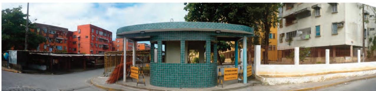
13d. Le mur, la grille et la double guérite en construction, en 2008
