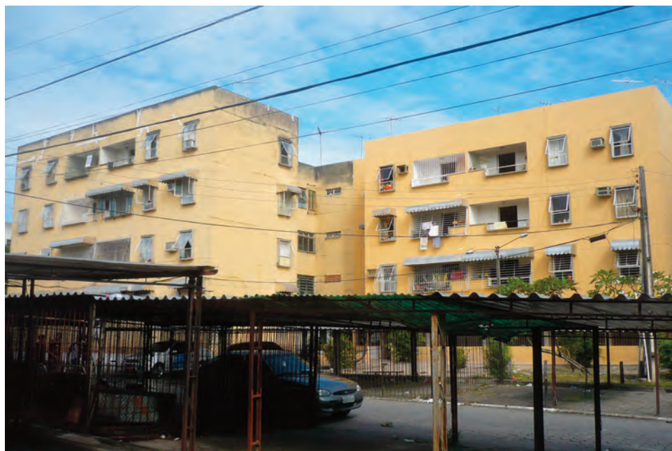
12d. Des bâtiments d'habitation et les stationnements couverts du Criazza, en 2008
