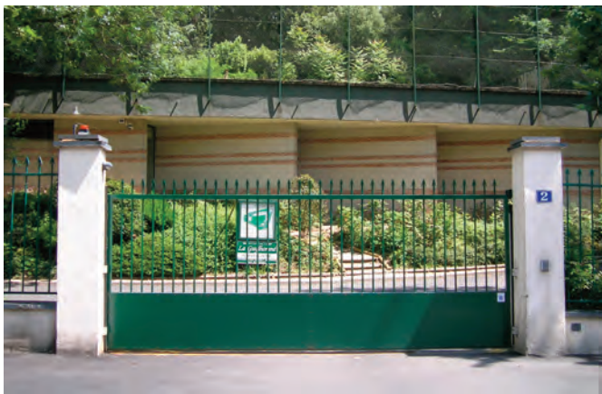
37d. L'entrée principale avec derrière, le parc, la piscine couverte et le court de tennis
