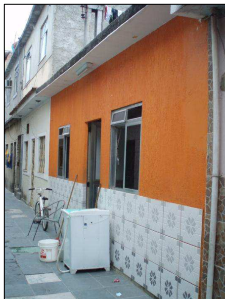
Photo 13 : Image d'une façade plus entretenue. Logement situé dans le couloir C (voir localisation du couloir sur le plan C de l'invasion « Palace » dans l' annexe 7 ).
