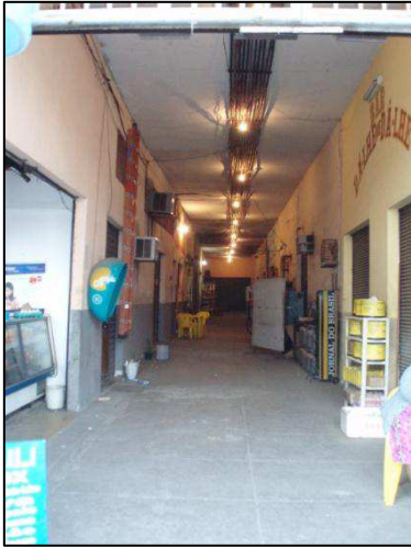
Photo 35 : La galerie avec des commerces installés, au rez-de-chaussée de l'immeuble principal.
