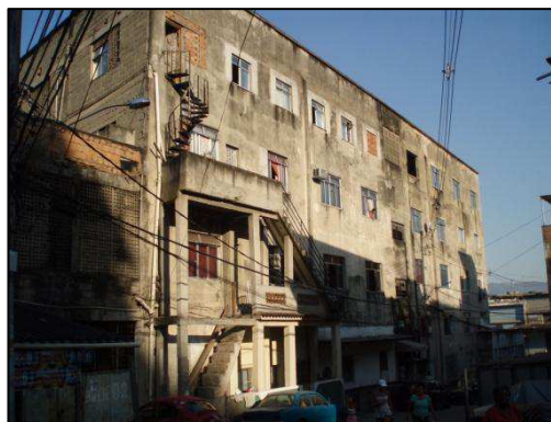
Photo 27 : Immeuble situé à l'entrée du terrain.
