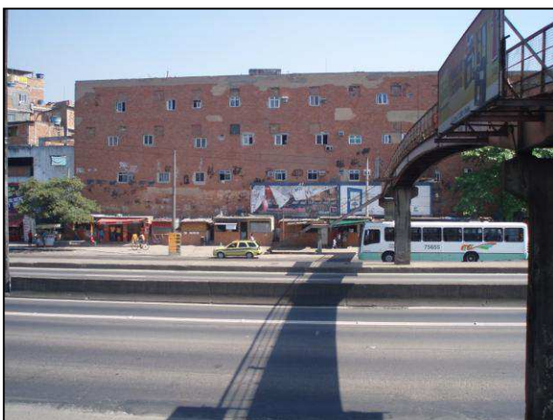
Photo 3 : Façade du « Palace » : sur l'Avenida Brasil et vue de la passerelle à droite.
