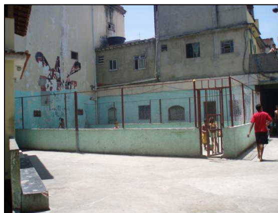
Photo 22 : Terrain de sports du « Palace ».
