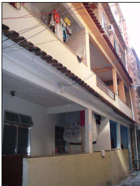
Photo 38 : Niveau atteint par les constructions situées sur les terrains libres de l'invasion « Chaparral ».
