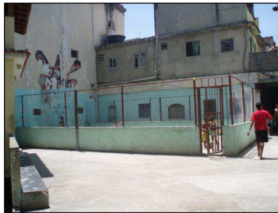
Photo 22 : Terrain de sports du « Palace ».
