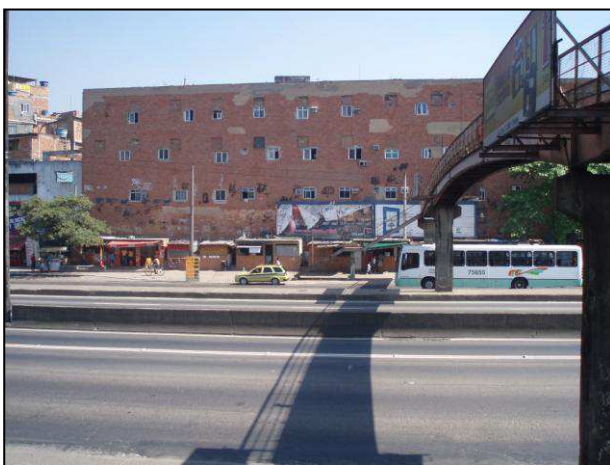
Photo 3 : Façade du « Palace » : sur l'Avenida Brasil et vue de la passerelle à droite.
