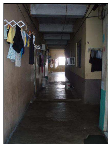
Photo 17 : Structure existant avant l'invasion, qui a déterminé l'occupation de l'espace dans le bloco 1.
