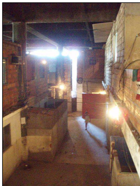
Photo 39 : Logements situés au premier étage de l'entrepôt qui donne sur l'Avenida Brasil.
