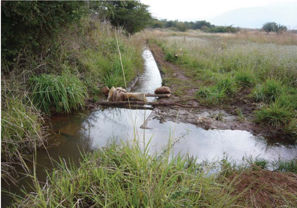
Photo 15. Canal en aval du périmètre de Raliphaswa : prise d'eau « illégale » de fortune, Nzhelele, Afrique du Sud
