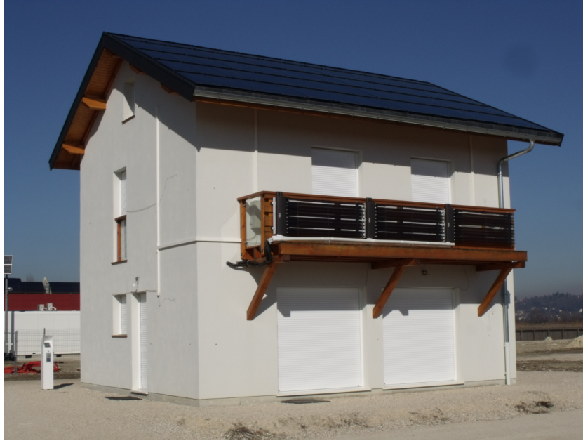
Figure 2.2 – Maison en béton banché avec isolation par l'extérieur
