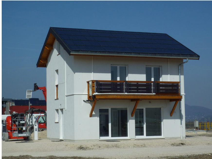
Figure 2.4 – Façade SUD de la maison BB
