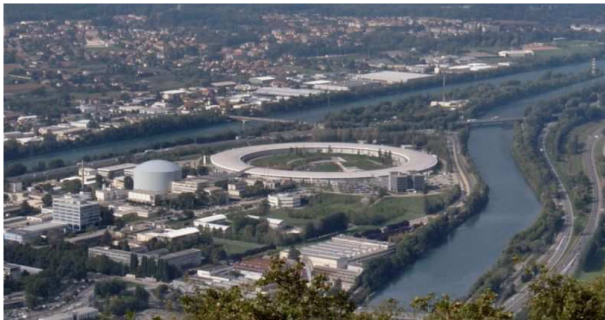
Figure 2- 16. L'anneau du synchrotron de l'ESRF à Grenoble
