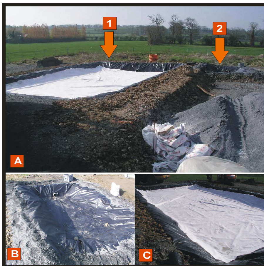
Figure VI-1: (A) partie de la chambre de dépôt où les sédiments ont été récupérés, (B) et (C) zone de préparation des mélanges.
