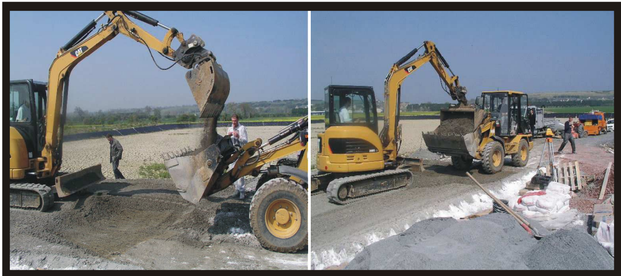
Figure VI-12 : Opération extraction du matériau.
