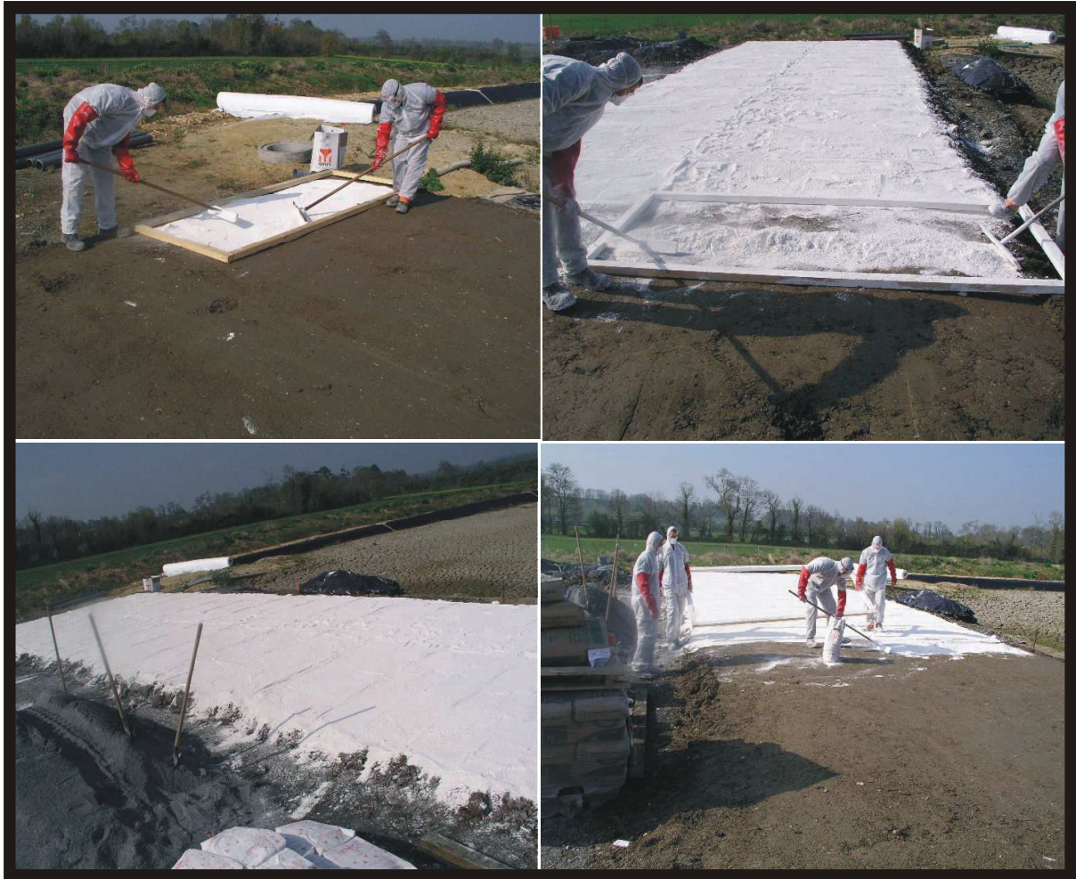
Figure VI-4 : Procède de mise en place de la chaux.
