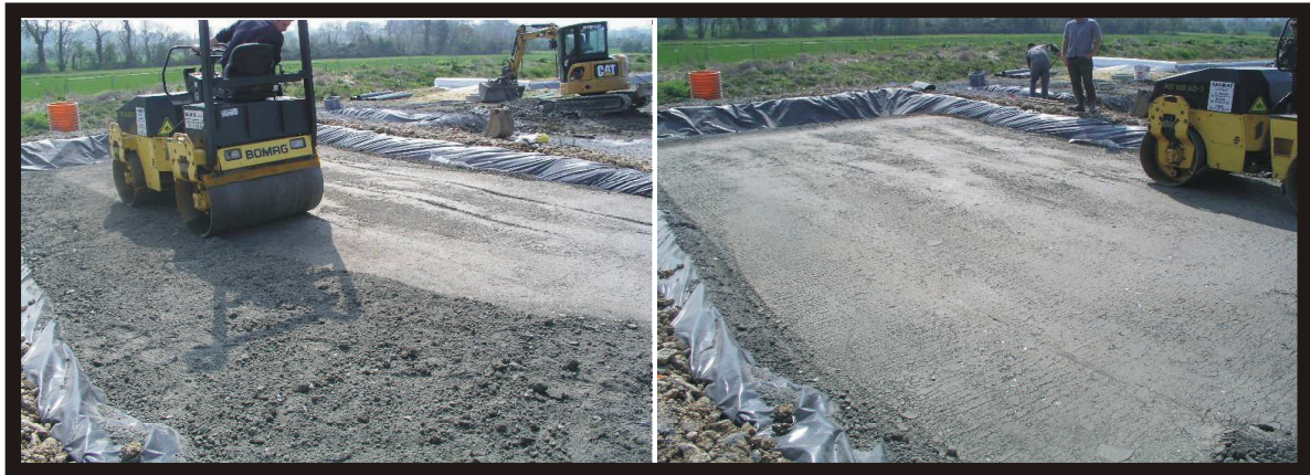
Figure VI-16 : Opération de compactage de la 2 ème couche
