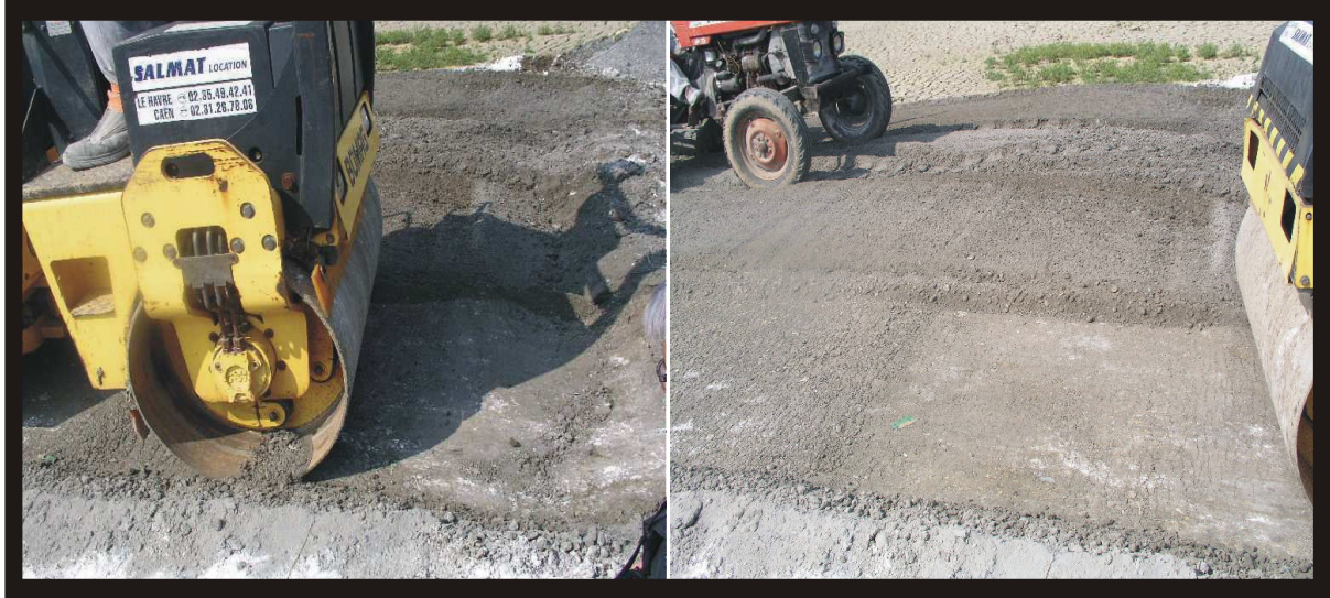
Figure VI-11 : Opération de compactage du matériau
