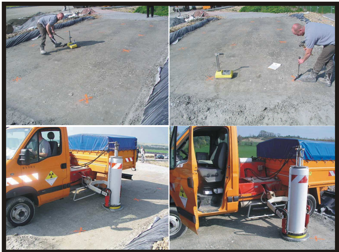
Figure VI-17: L'opération de mesure de portance par la Dynaplaque 2.
