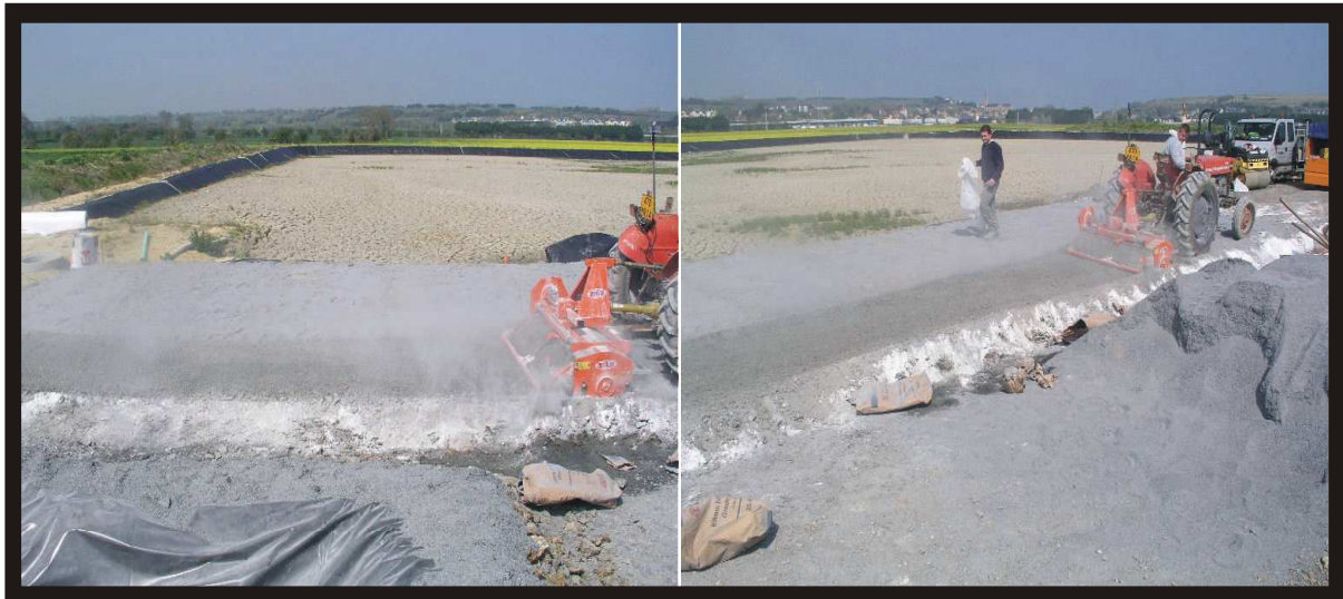
Figure VI-9 : Procès d'une mise en place de fumée de silice
