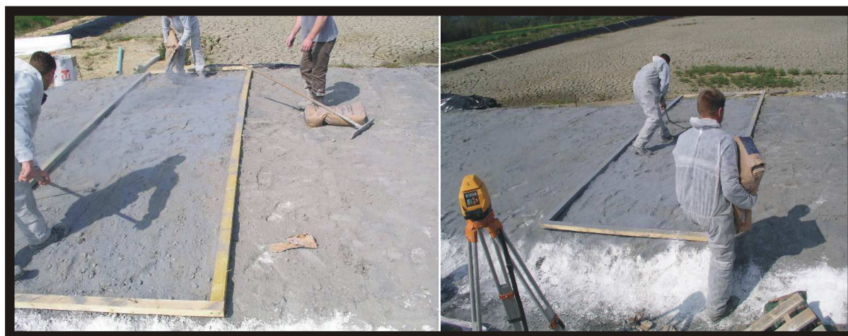
Figure VI-8 : Mise en place de fumée de silice.
