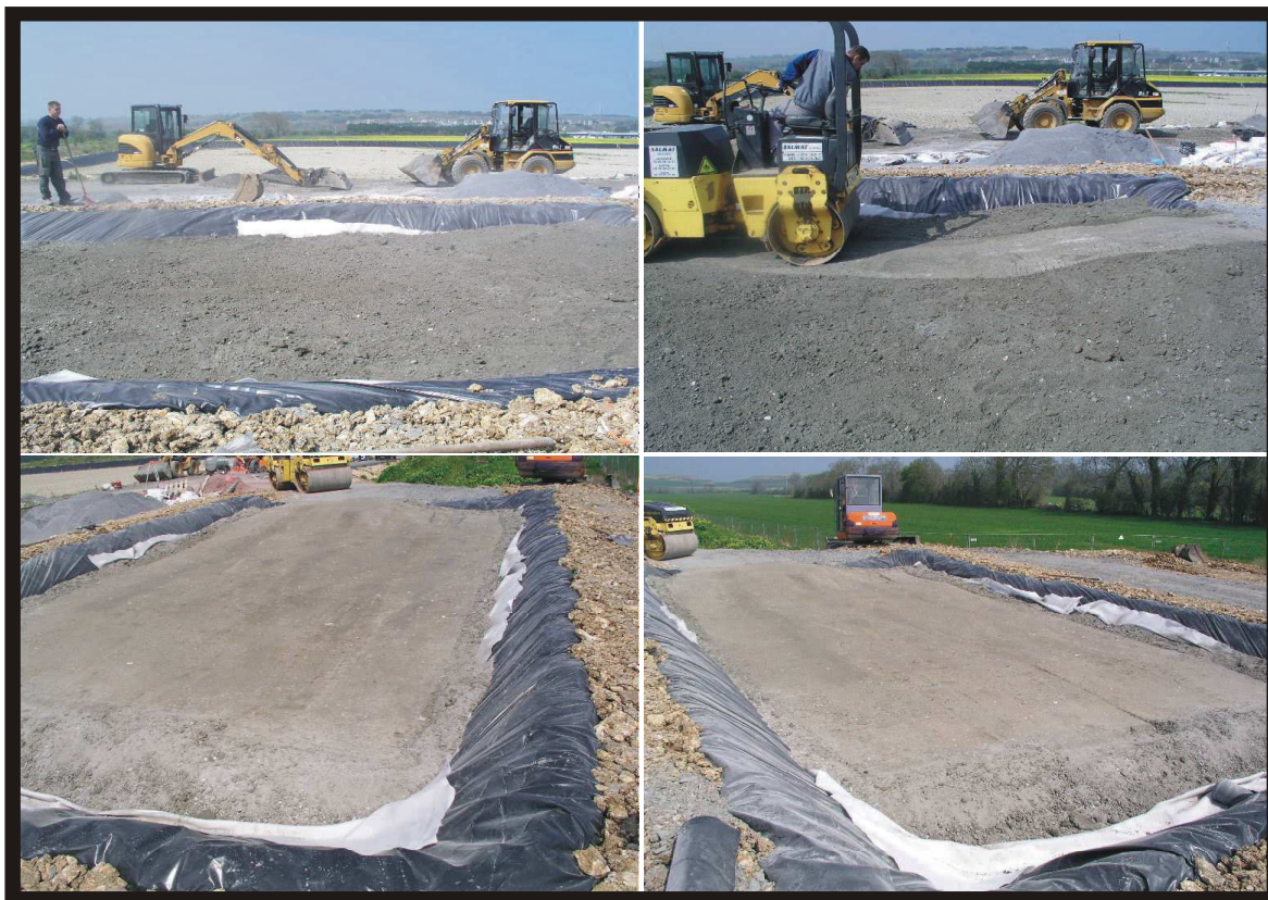
Figure VI-14 : l'opération de compactage la 1 ère couche.
