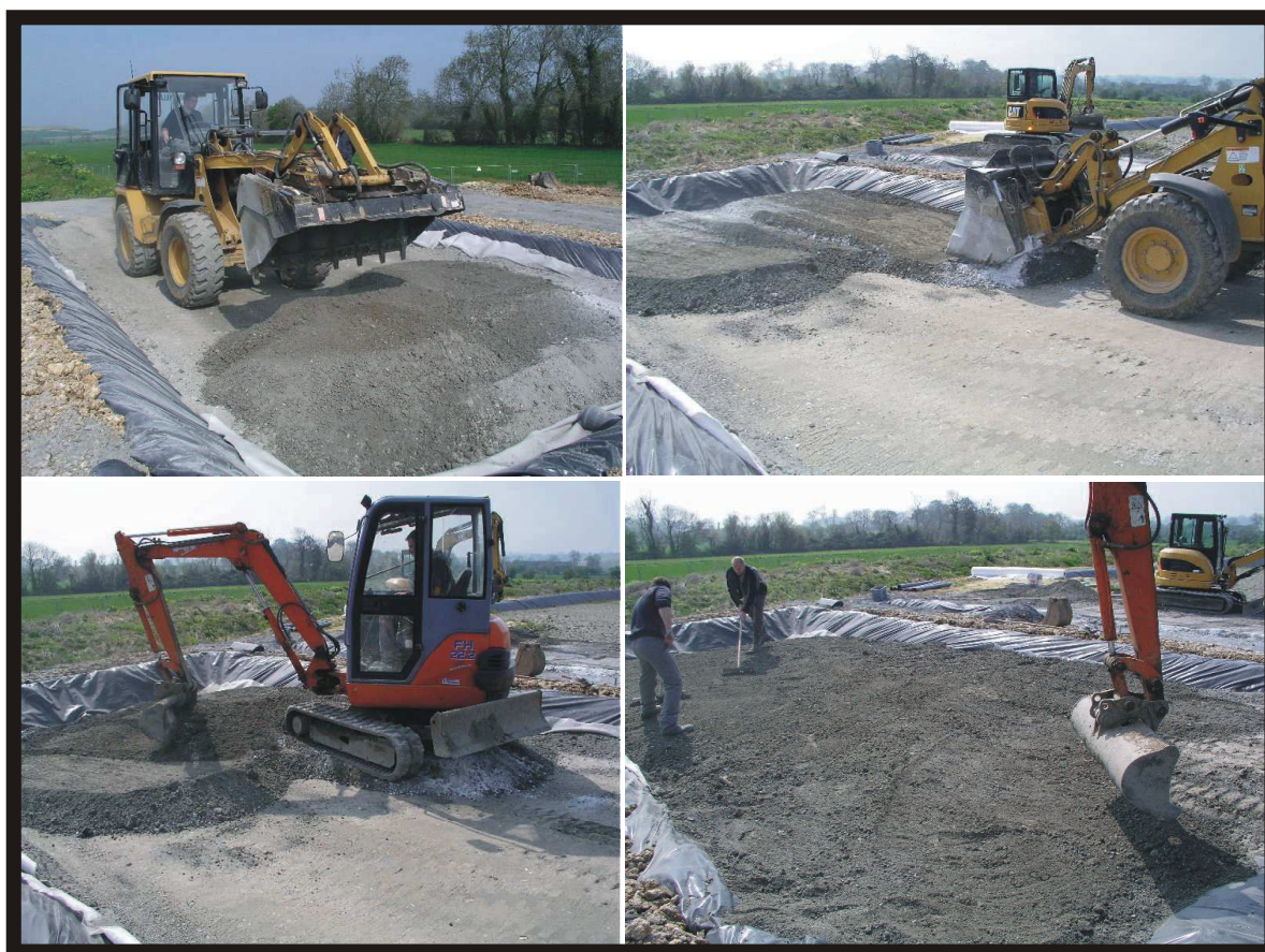
Figure VI-15 : Opération de mise en matériau de la 2 ème couche
