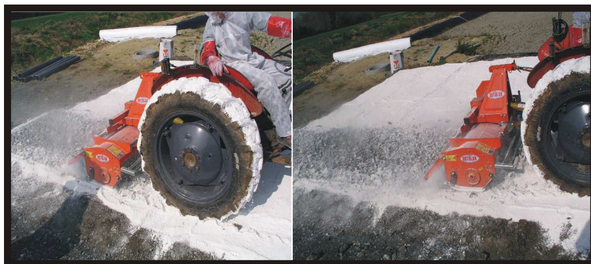
Figure VI-5 Malaxage en place
