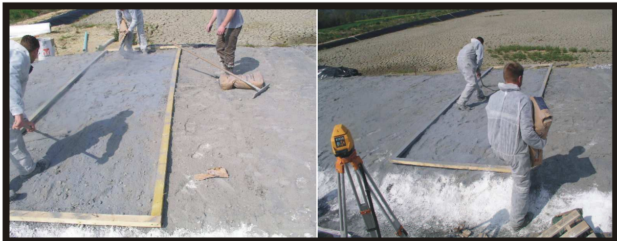
Figure VI-8 : Mise en place de fumée de silice.
