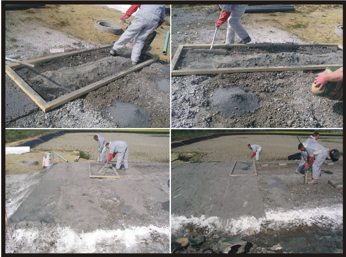
Figure VI-7 : Mise en place du sable et du ciment
