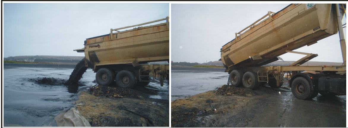
Figure III-3 : Déversement des sédiments dans la chambre de dépôt par camion
