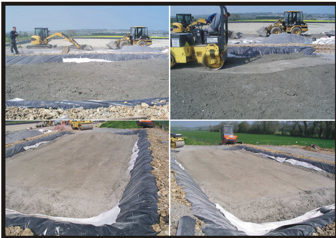
Figure VI-14 : l'opération de compactage la 1 ère couche.
