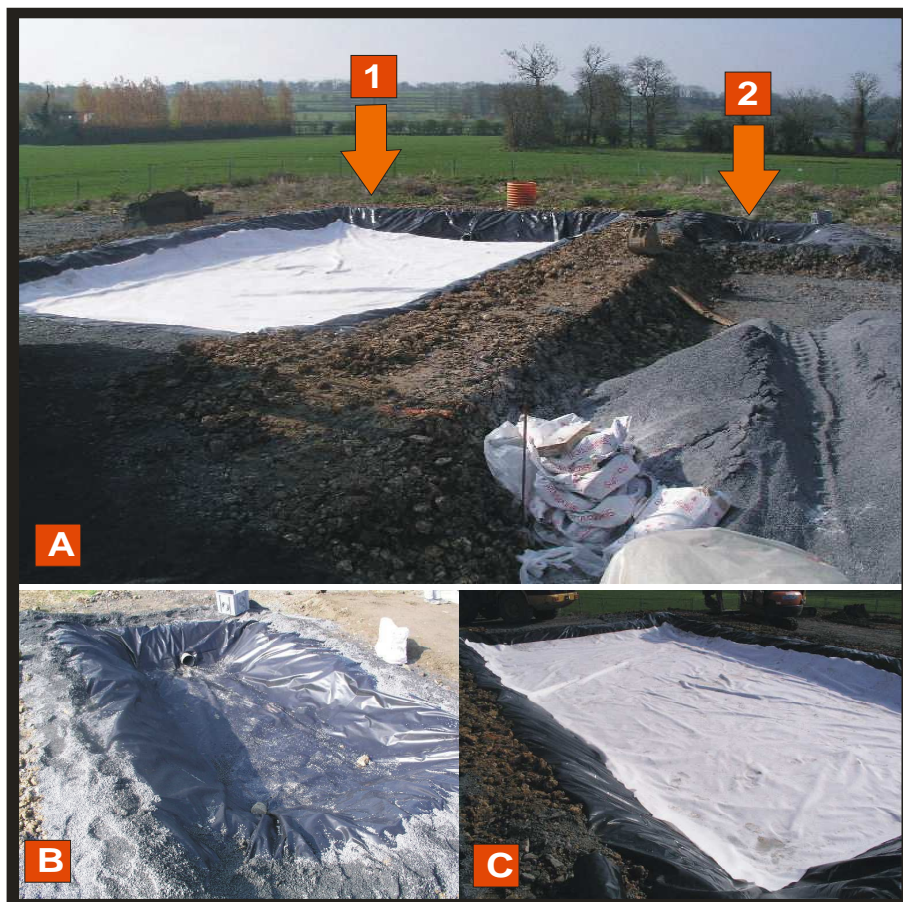
Figure VI-1: (A) partie de la chambre de dépôt où les sédiments ont été récupérés, (B) et (C) zone de préparation des mélanges.
