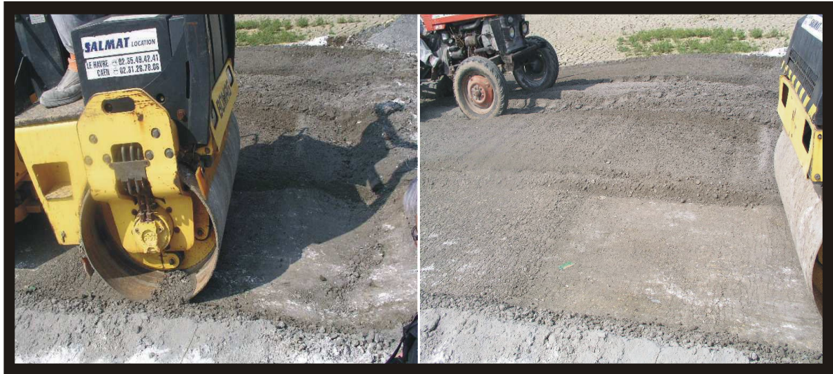
Figure VI-11 : Opération de compactage du matériau
