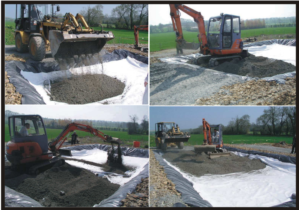
Figure VI-13 : Opération de mise en du matériau sur la planche d'essai.
