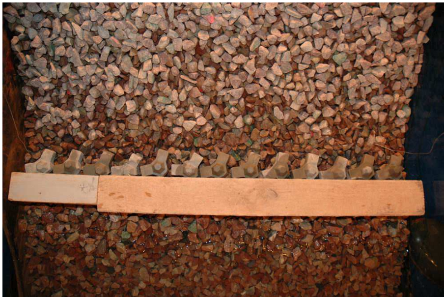
FIG. IV.1: Première ligne de blocs posés sur un Plan De Pose Rangé (PDPR)
