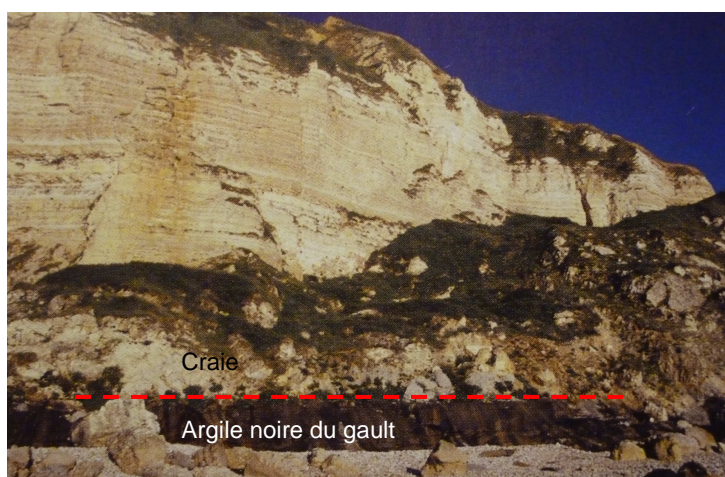
Photo I- 8 : Limite Crétacé inférieur (Albien) – Crétacé supérieur (Craie) visible au niveau de la falaise de Saint Jouin (76) (Ragot et Ragot, 2008)
