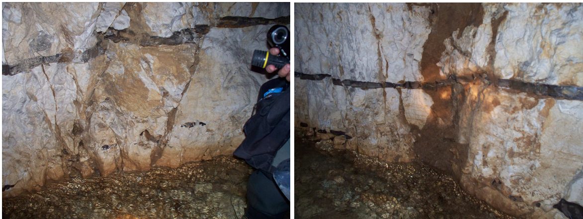
Photo III- 3 : Exemples de micro failles présentes dans la galerie de la Bruisseresse. Le rejet estimé de chaque micro faille est de 5 cm
