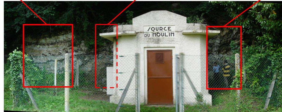
Figure II- 53 : Eléments descriptifs d'une zone de broyage de part et d'autre de la source du Moulin B marqueur de la présence de la faille du Moulin ou faille Ff
