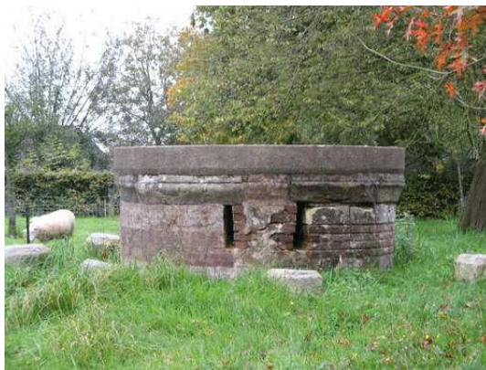
Photo I- 5 : Piézomètre des Trois Pierres (00755x0006/S1)
