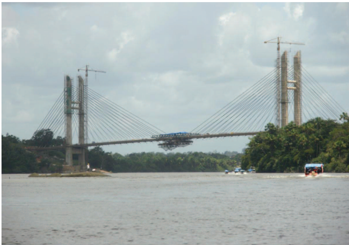
Photo 22. Le pont sur l'Oyapock en passe d'être achevé (photo S. Granger, avril 2011).
