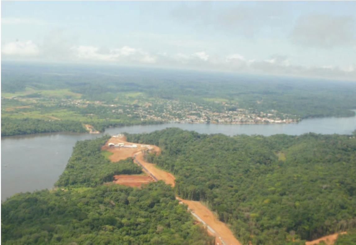
Photo 21. La route d'accès du côté français avec l'agglomération d'Oiapoque en arrière-plan, avant le début des travaux de construction du pont (photo S. Granger, août 2010).
