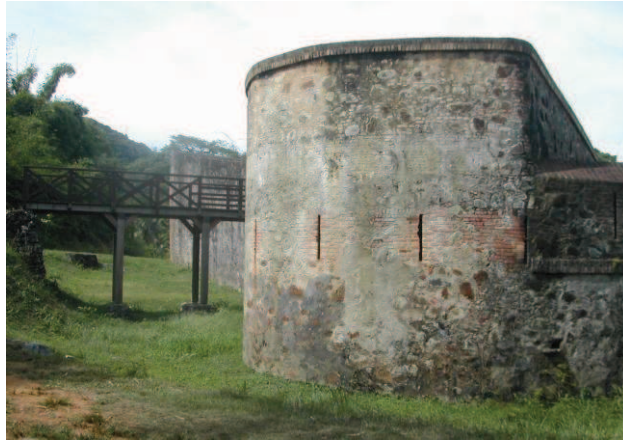
Photo 9 : le fort Diamant à l'embouchure du fleuve Mahury, construit en 1849 sur les ruines d'un ancien fort détruit par les Portugais, en pleine tension avec le Brésil (cliché S. Granger, 2002). Une des rares traces encore visibles des conflits de l'époque.
