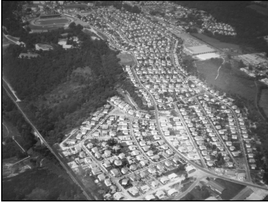
Photographie 19 : Vue aérienne du lotissement des Castors Landais « Barbe d'Or » à Mont-de-Marsan, fin des années 1960 (Source : Archives des Castors Landais)
