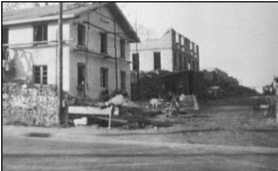
Photographie 9 : Les deux premières maisons émergent du chantier bayonnais en 1952 (Source: Archives privées Castors de Bayonne)
