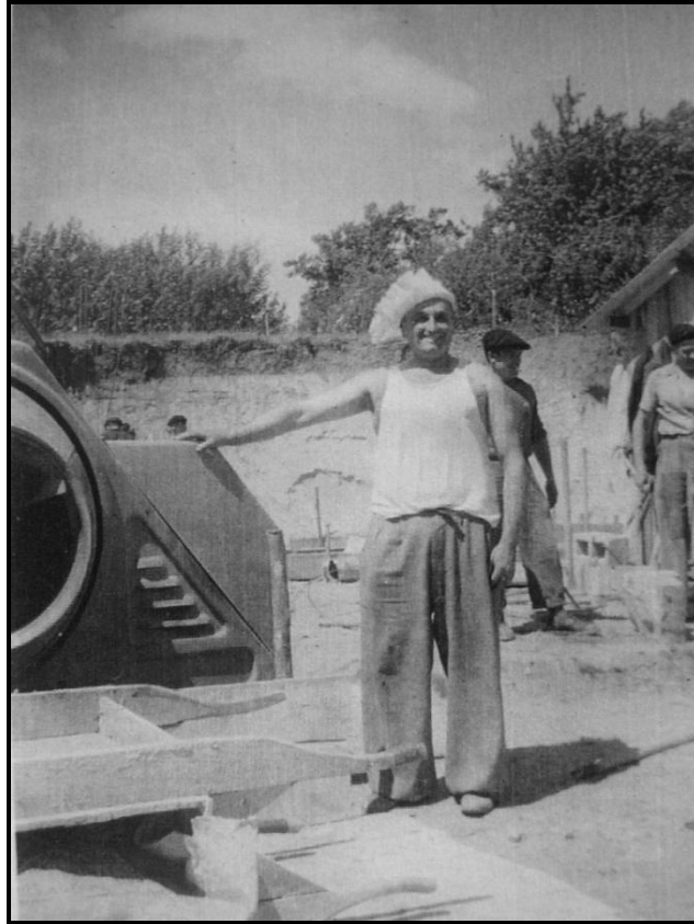
Photographie 7 : La bétonneuse du groupe bayonnais, 1951 (Source : Archives privées Castors de Bayonne)
