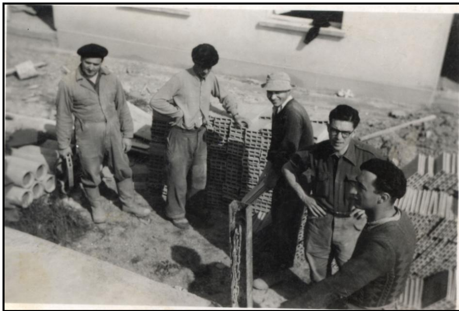
Photographie 5 : Le terrassement du terrain et l'édification des fondations, 1951 (Source : Archives privées Castors de Bayonne)
