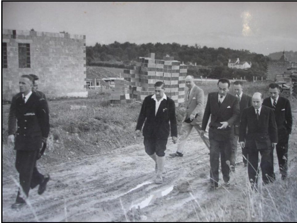
Photographie 22 : Visite du Préfet Delaunay sur le chantier des Castors du "Toit Basco-béarnais", au début du chantier, 1953 552 (Source : Archives privées Castors de Pau)
