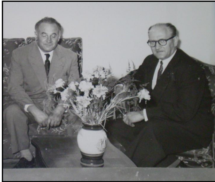
Photographie 17 : Visite de Guy Mollet sur les chantiers des Castors Landais, le 9 octobre 1955, ici avec Charles Lamarque-Cando dans une maison « Castor » terminée (source : Archives des Castors Landais)
