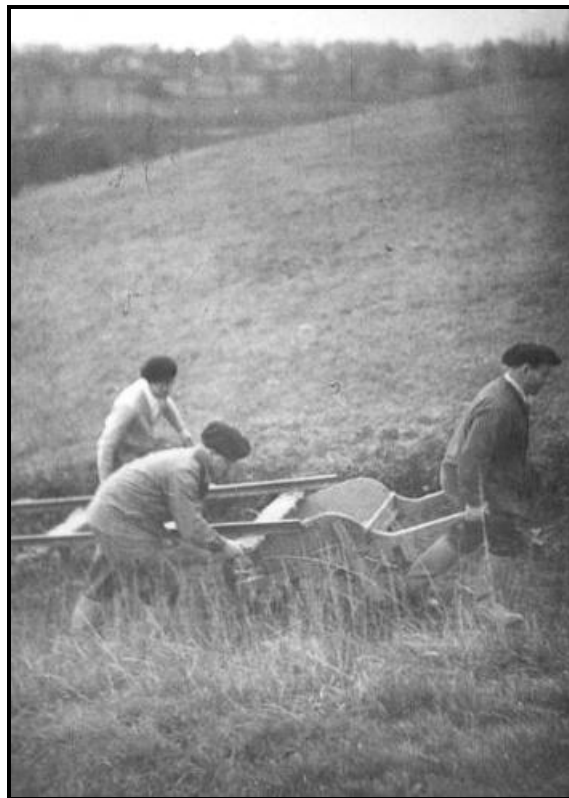
Photographie 4 : Les brouettes à rails, 1950 (Source : Archives privées Castors de Bayonne)
