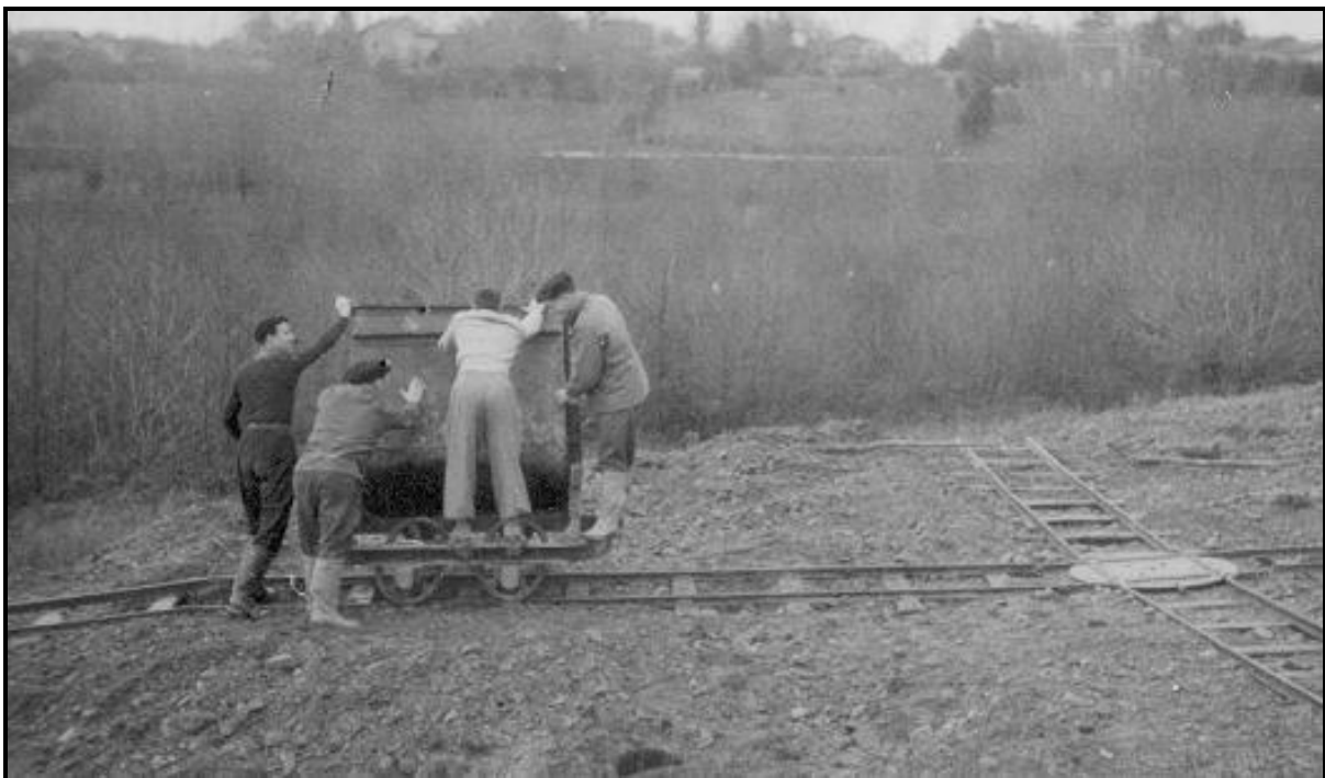
Photographie 6 : Les wagonnets, symboles du chantier bayonnais, 1949-1951 (Source : Archives privées Castors de Bayonne)
