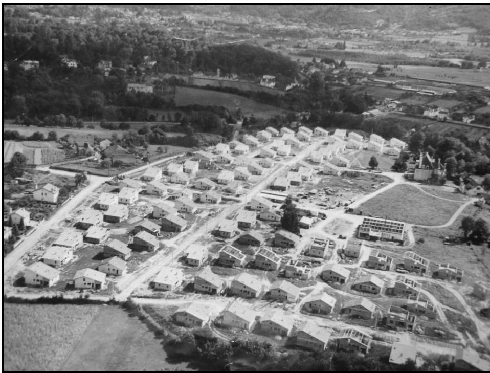
Photographie 21 : Vue aérienne du chantier du « Toit Basco-Béarnais » à Pau en 1954 (Source : Archives privées Castors palois)
