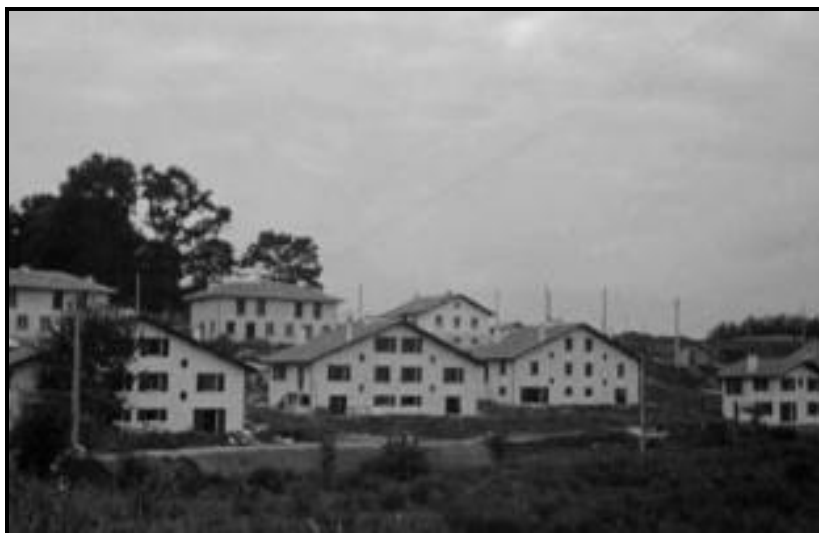
Photographie 10: La cité des Castors vers la fin du chantier, 1953 (Source: I.N.A.)
